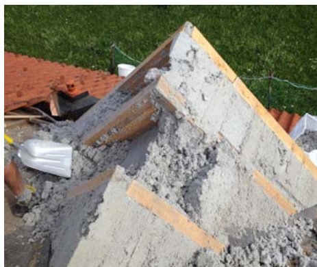
Beim Umbau einer Dachgaube eines vor 17 Jahren mit Zellulose gedämmten Hauses stießen die Arbeiter ebenfalls auf unversehrte, lückenlose Dämmung
