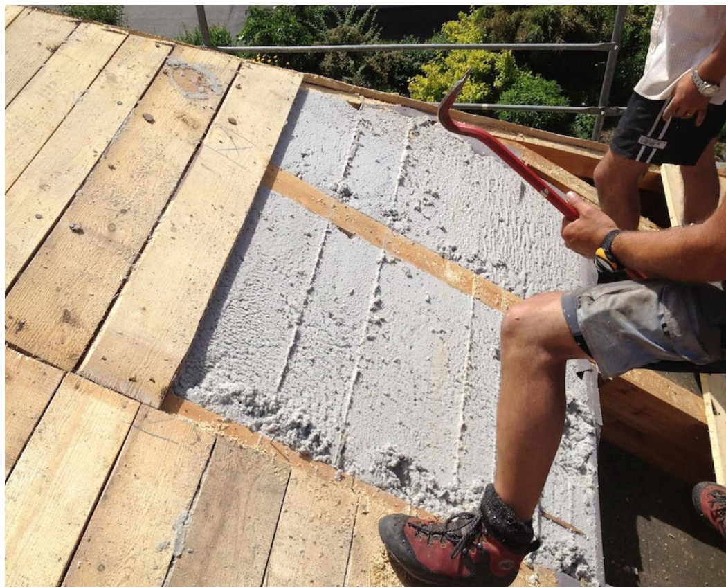
Die Zimmerleute entfernen die Schalung, auch darunter erkennt man unversehrte, formstabile Zellulose
