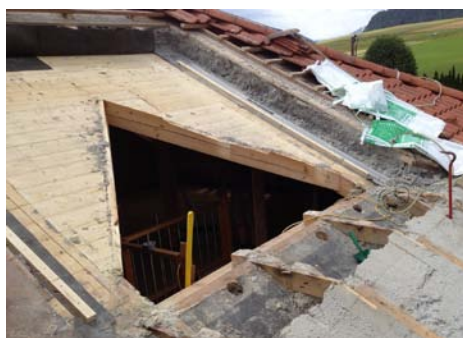
Stück für Stück wird die Gaube freigelegt
